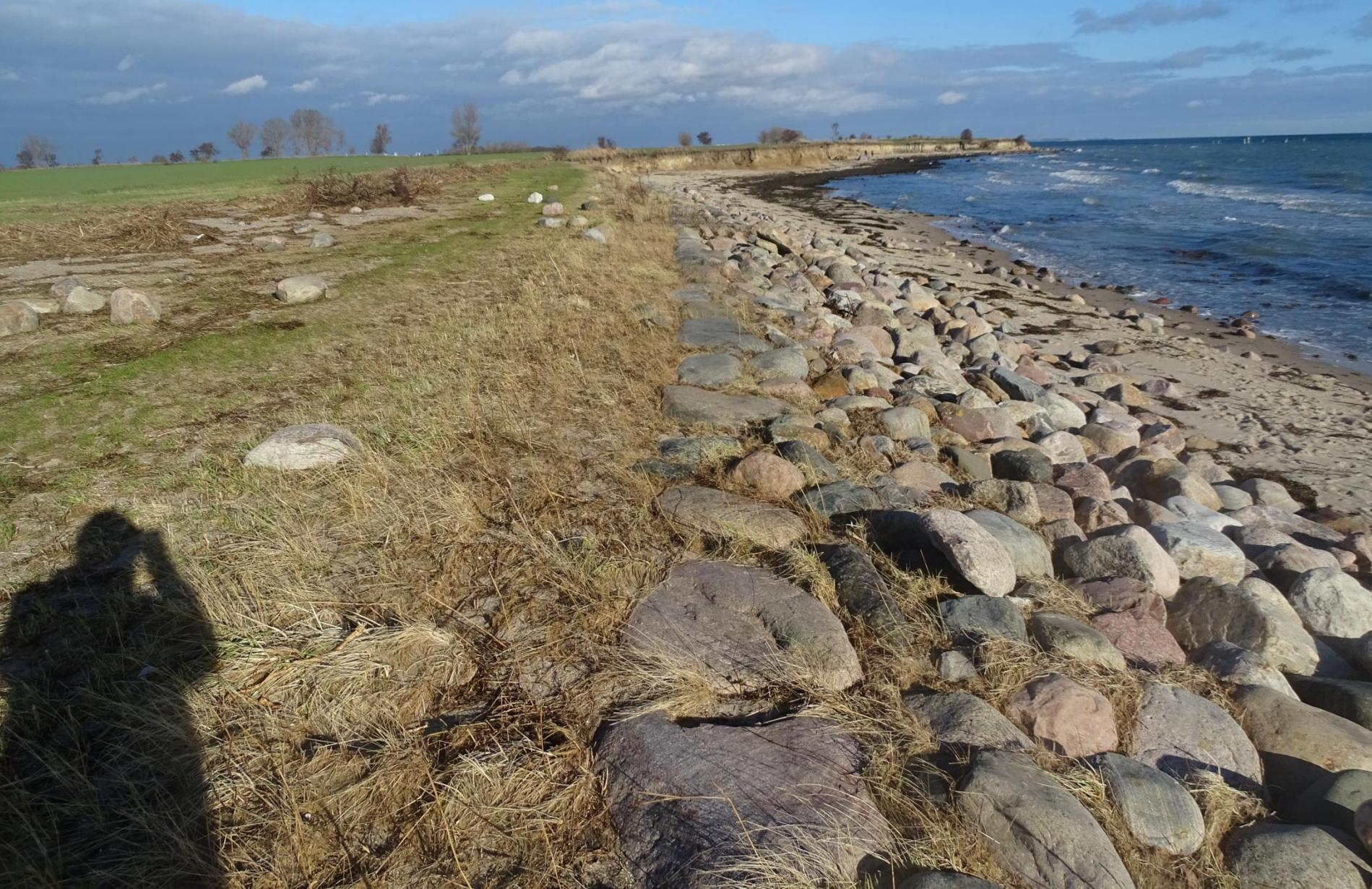
Fußsicherung eines Deiches in mittelschwerem Wellenauflauf mit Findlingen auf Meeresboden. Hier Verrollungs-Zustand nach 4 Jahren (2022)
